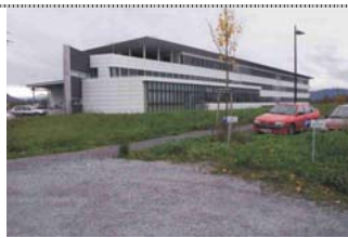
Photo 14 : Medienhaus : des places de stationnement sont réservées près de l'entrée aux véhicules de covoiturage.
